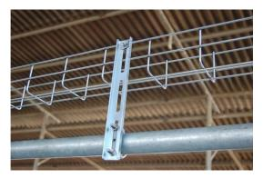
3. Fije el ducto para cables a los soportes mediante los tornillos de sujeción.
