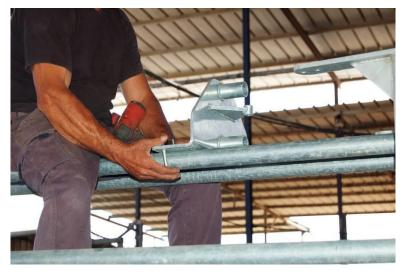
3. Inserte los tubos de 1" en la posición correcta en la parte posterior de la estructura. Coloque la corredera sobre los tubos.
