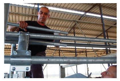
4. Conecte la estructura frontal a los tubos. No apriete los tornillos.
