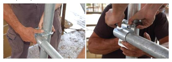
4. Arme las bases del cuarto arco y coloque un solo tubo lateral de 1,5" en el punto de unión más bajo opuesto usando los soportes y tornillos en U.
