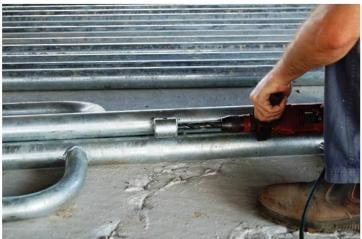
3. Coloque las placas de sujeción en la parte superior de las hojas de la tranquera.
