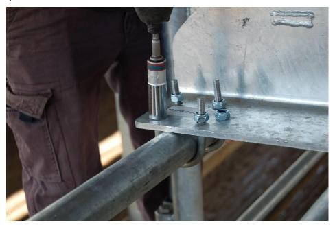
11. Arme los pistones con los tornillos M16x60. De ser necesario, equilibre el pistón con las tuercas M16.
