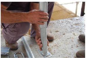
3. Coloque un solo tubo lateral de 1,5" en el punto de unión más bajo usando los soportes y tornillos en U.
