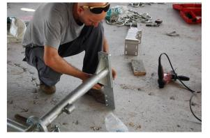
6. Coloque la placa de sujeción en el portón.
