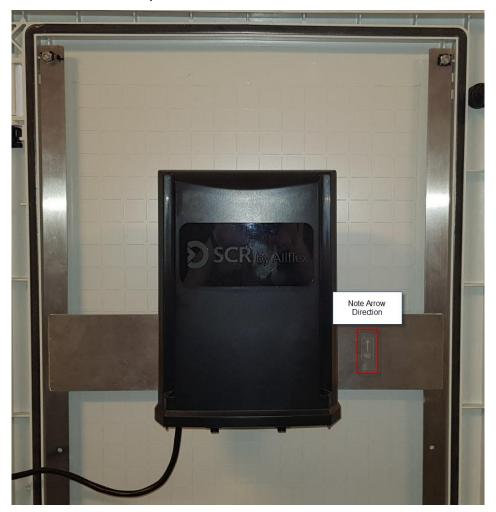
a. Use los tornillos provistos para fijar el soporte a la H montada en la puerta de la caja de conexión.
